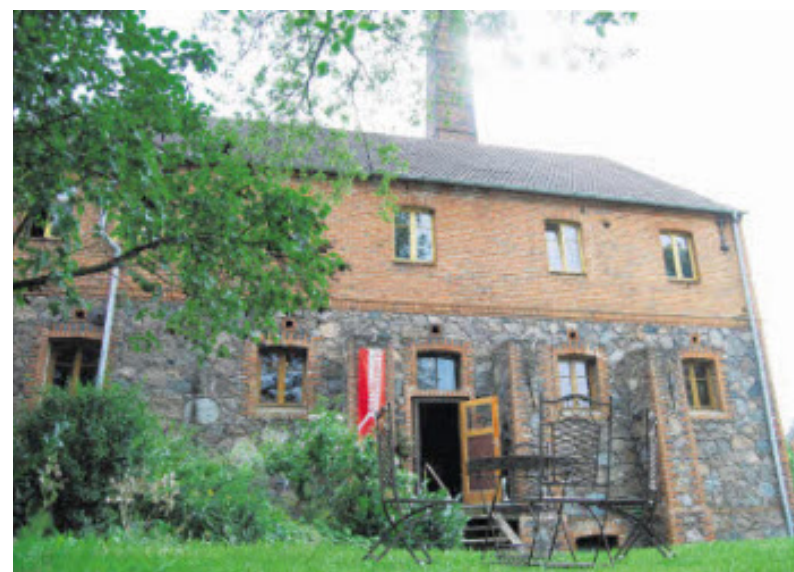
Über zehn Jahre wurde die alte Brennerei saniert.
